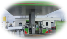
dla stacji paliw
